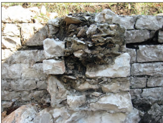
Sl. 5. Presjek pregradnog zida B2
