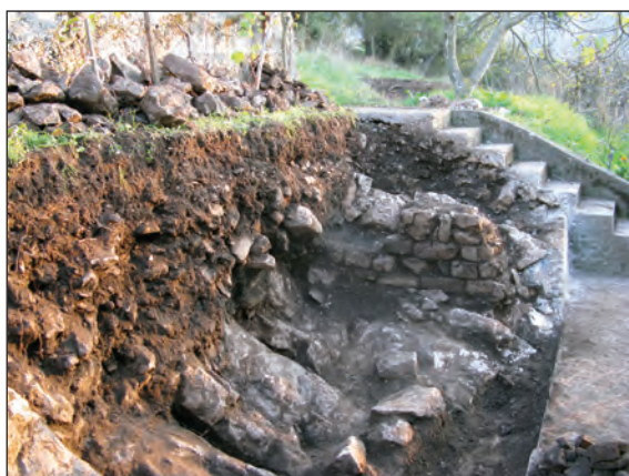
Sl. 6. Pregradni zid B3
