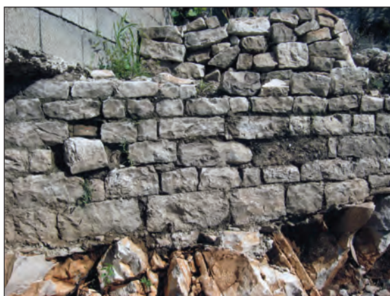
Sl. 3. Blok sedre i fragmenti tegula ugrađeni u antički zid A
