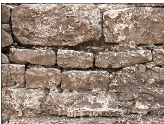
Sl. 7. Ostaci mozaika u žbuci ispod antičkog zida
